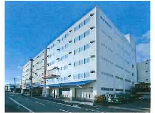
2013年9月に稼働した4号棟（手前）
